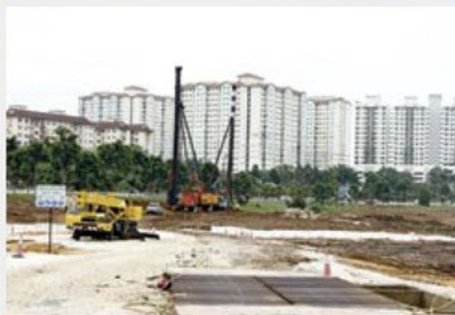
Lawatan ke tapak projek MRT di Kota Damansara.
