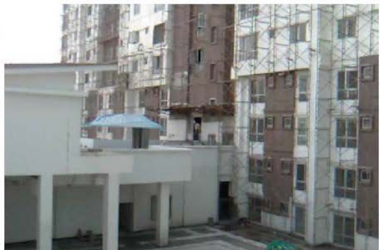
Lawatan ke kawasan pembangunan SOHO, Menara Axis, Ampang Jaya pada 29hb. Mac 2010.
